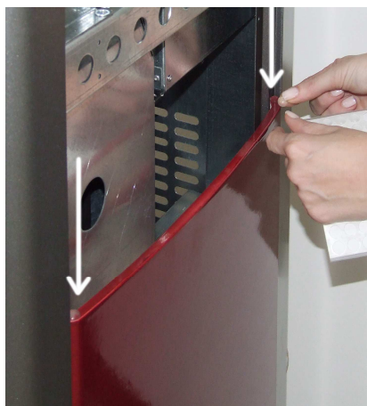
4) Coller les tampons silicone aux angles de l'élément céramique.
